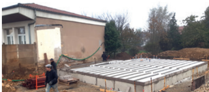
15 école maternelle, travaux en cours
